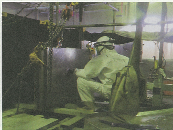
設備の解体・切断状況
