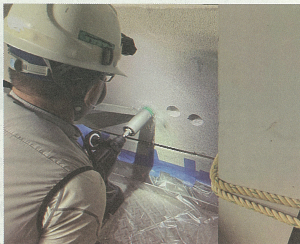
壁材の試料採取の状況
